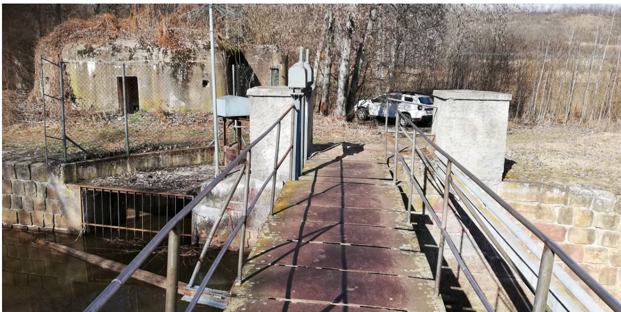
Pohled na levé zavázání s patrným špatným technickým stavem lávky.
