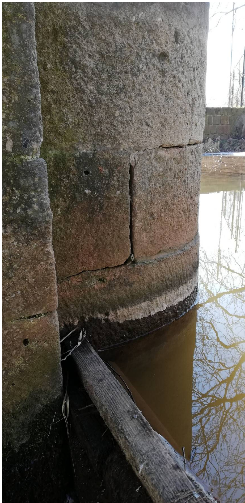
Detail celoobvodové trhliny na středovém pilíři.
