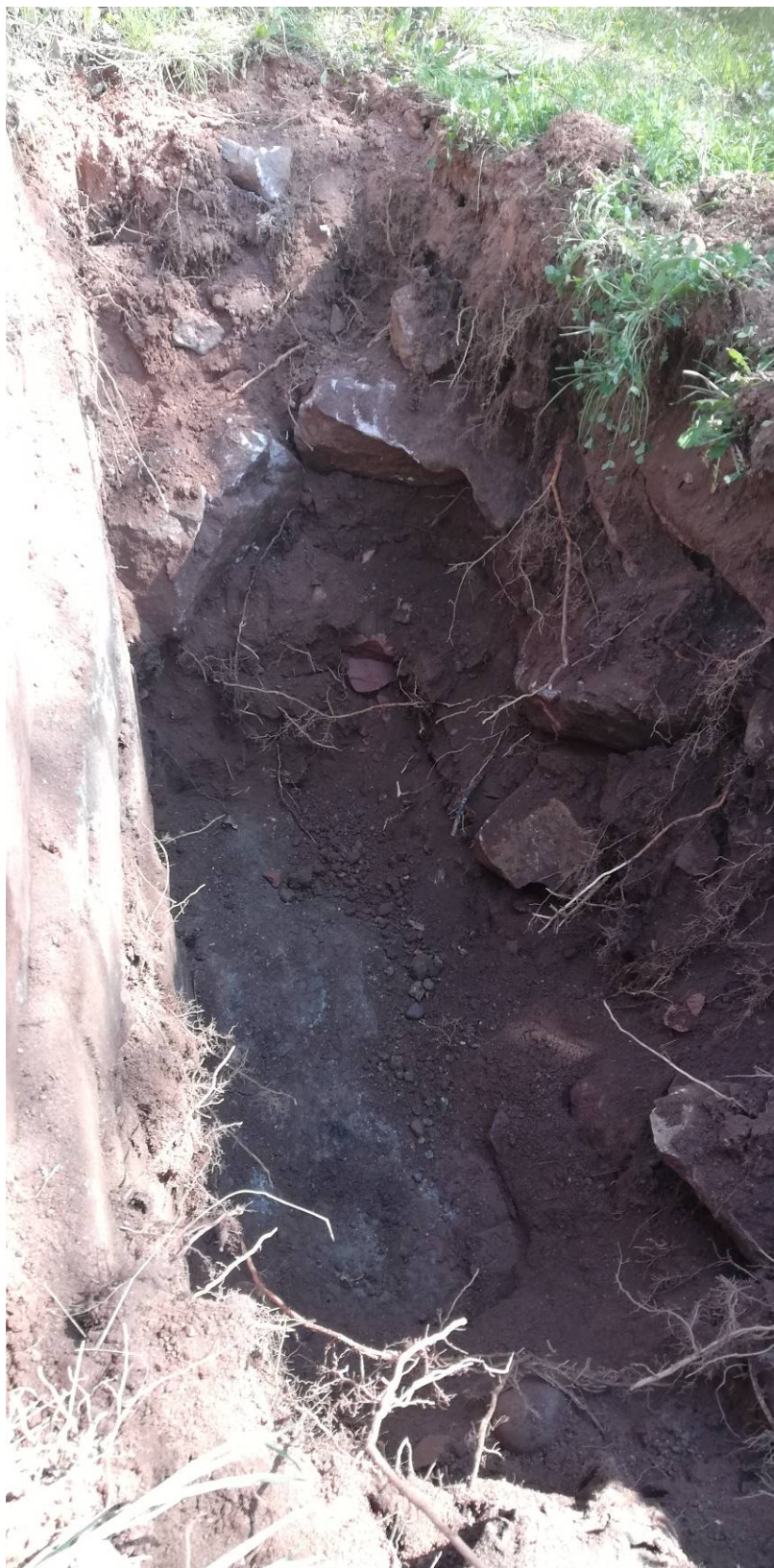
Pohled na kopanou sondu na pravém břehu – patrný betonový pas v úrovni cca -2m.
